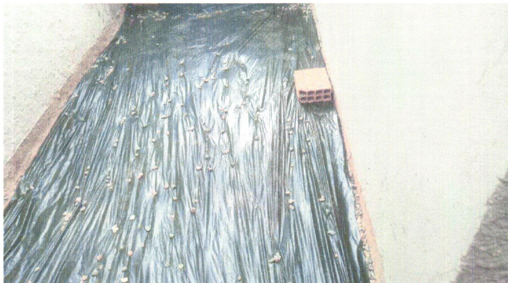
FOTO 12 – APLICAÇÃO DE LONA PLÁSTICA PARA EXECUÇÃO DE PAVIMENTOS DE CONCRETO. AF04/2022
