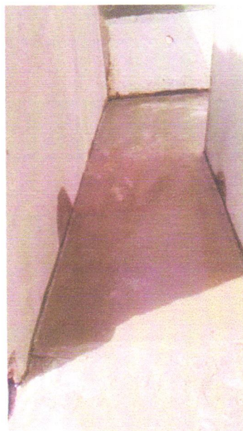
FOTO 01 - PISO EM CONCRETO 20MPA PREPARO MECÂNICO, ESPESSURA 7CM. AF_09/2020
