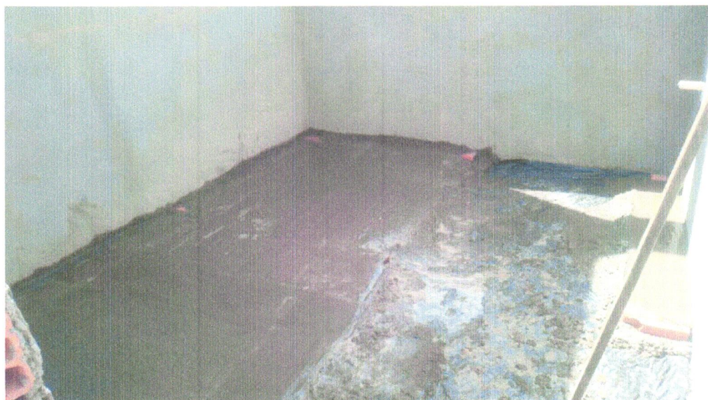
FOTO 10 – PISO EM CONCRETO 20MPA PREPARO MECÂNICO, ESPESSURA 7CM. AF_09/2020
