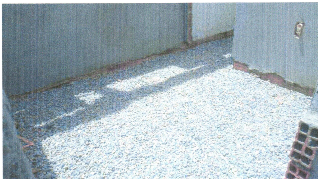
FOTO 05 – Lastro de brita graduada apiloada e=10cm
