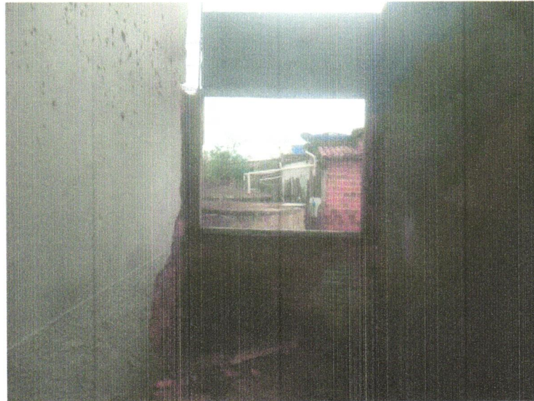
FOTO 03 - VERGA PRÉ-MOLDADA PARA JANELAS COM ATÉ 1,5 DE VÃO. AF_03/2016
