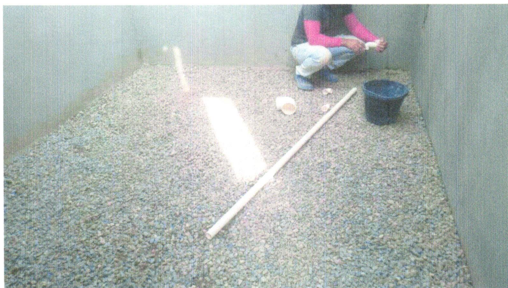
FOTO 05 – Lastro de brita graduada apiloada e=10cm
