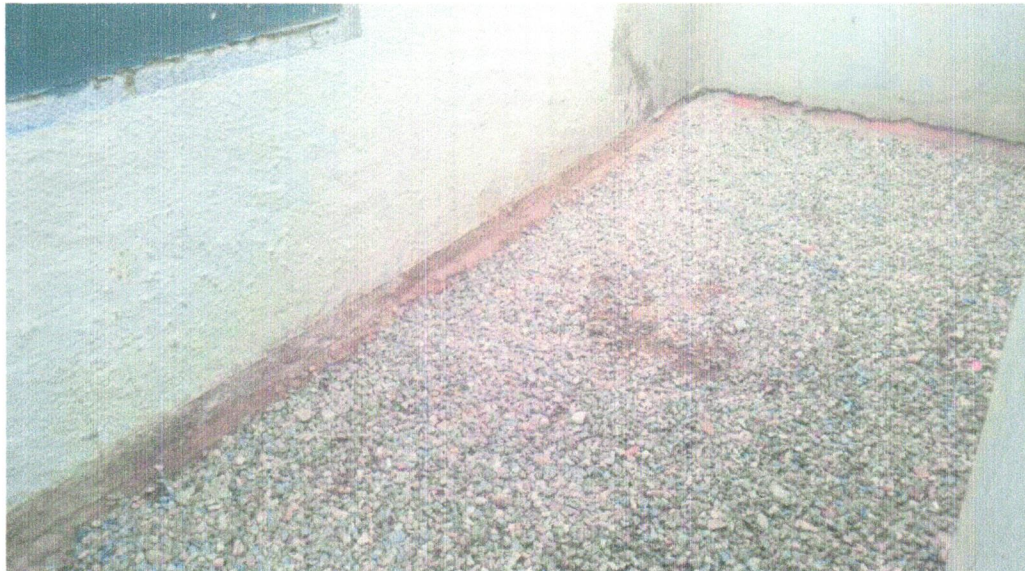
FOTO 11 - Lastro de brita graduada apiloada e=10cm
